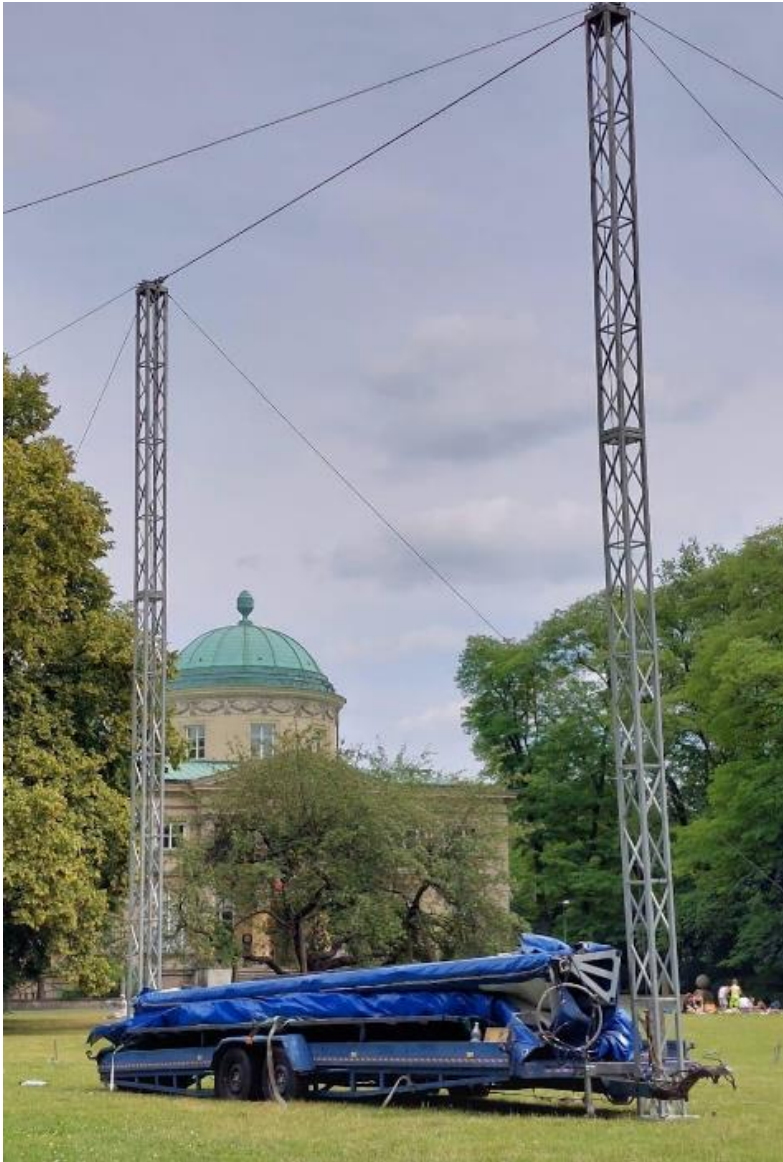
Zdjęcie nr 2. Namiot cyrkowy podczas montażu (przed podniesieniem)
